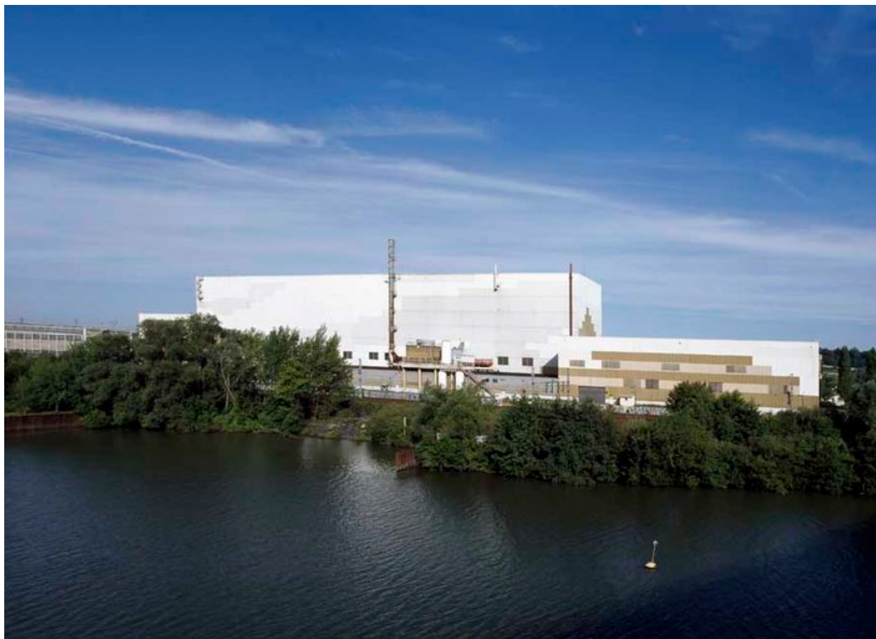
Bâtiment du recuit-continu.
