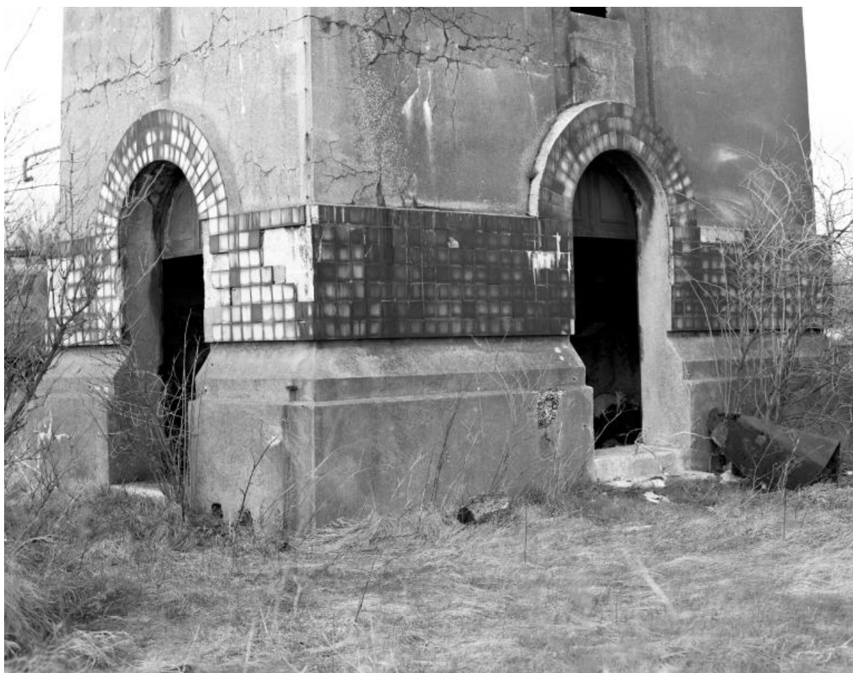
La base de la tour d'aiguillage.
