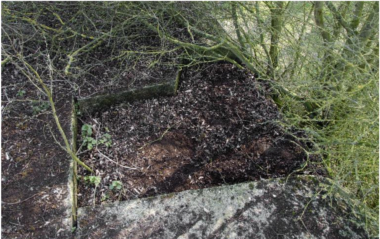
Cuve a mitrailleuse sur le couvrement
