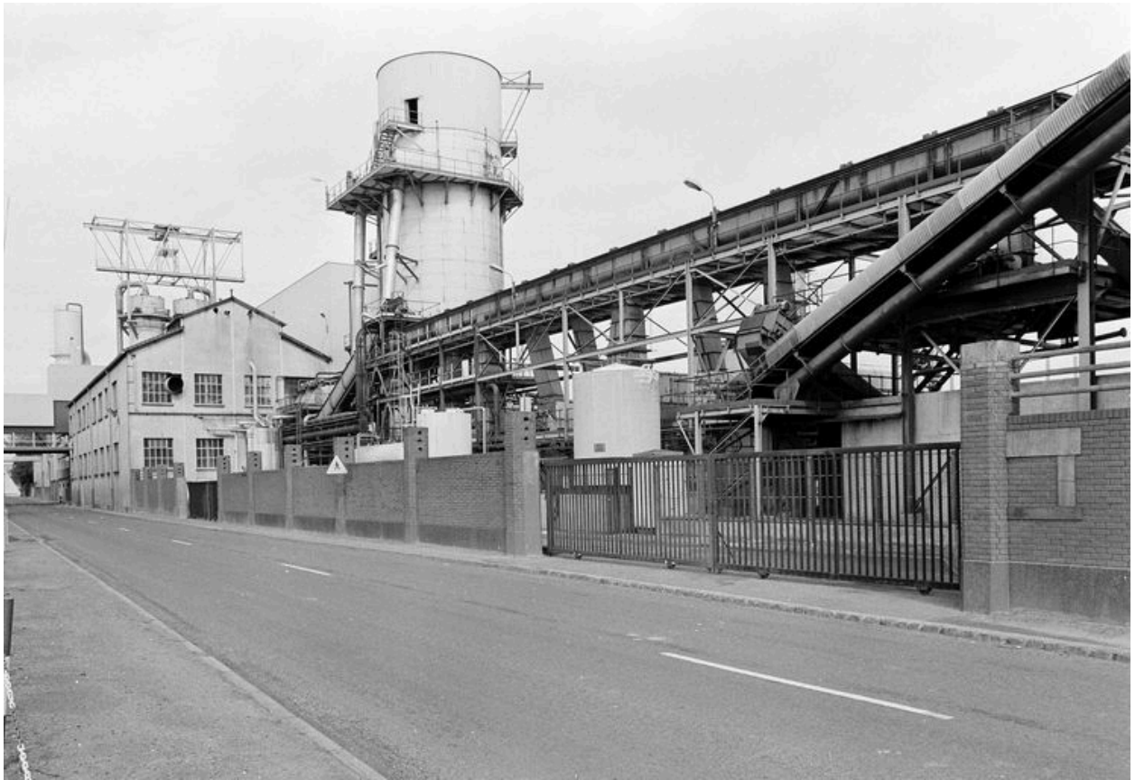
Vue générale de l'usine, flanc est.
