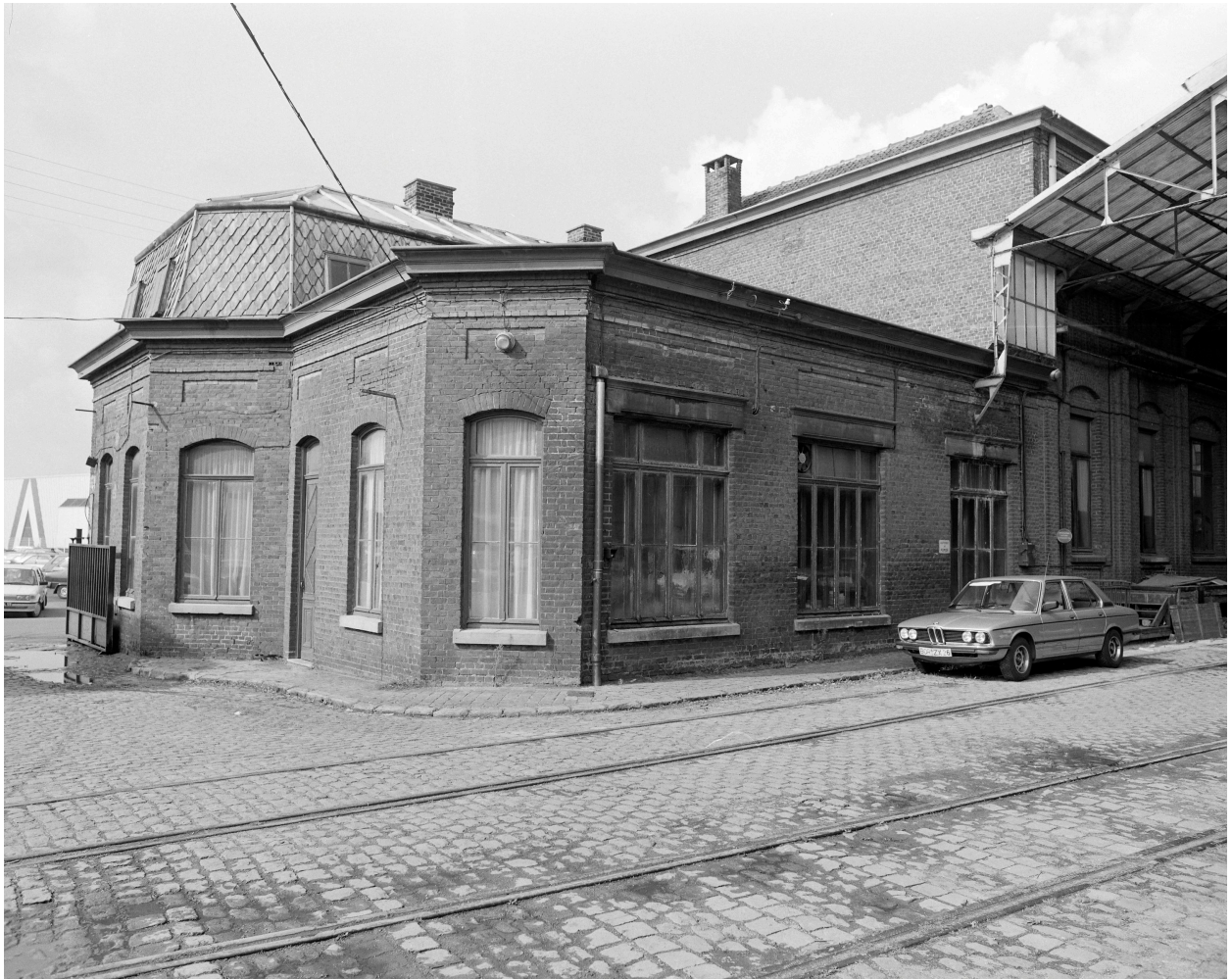
Bureaux depuis la cour. Vue prise vers l'ouest.
