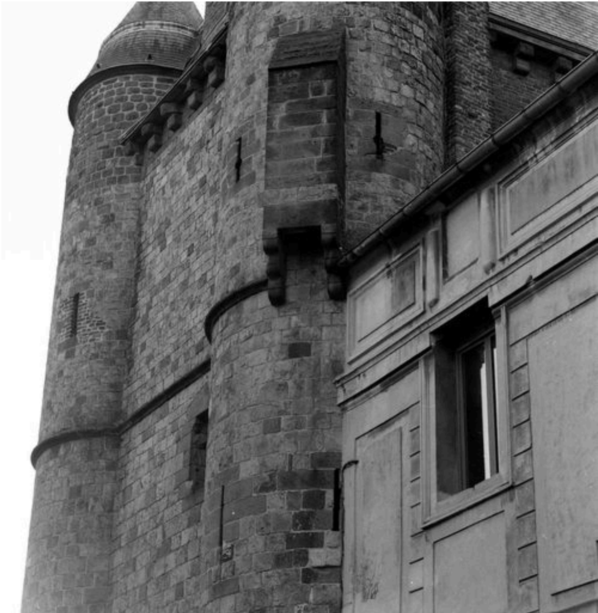
Corps de logis médiéval, façade en retour rue de la Bibliothèque, vue partielle : tourelles est et nord ; sur celle-ci, les latrines en encorbellement.
