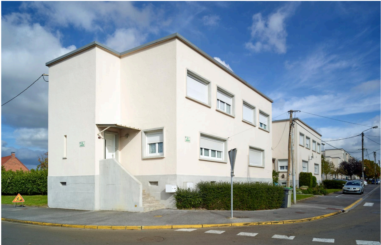
Vue des pavillons situés aux extrémités de l'opération (bloc C), prise depuis la rue.
