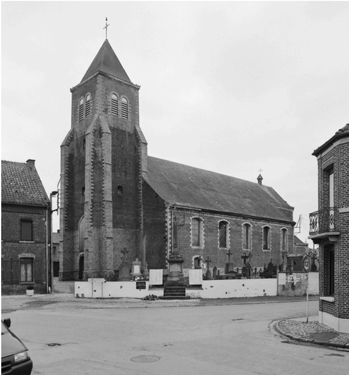
Vue générale de trois quarts, depuis la rue de la Place.
