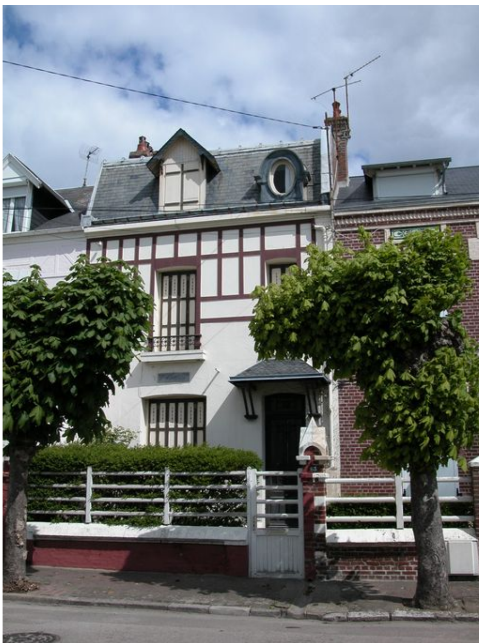
Maison dite L'Esterel, 'normandisée', avenue Carnot (1988 BB 37).
