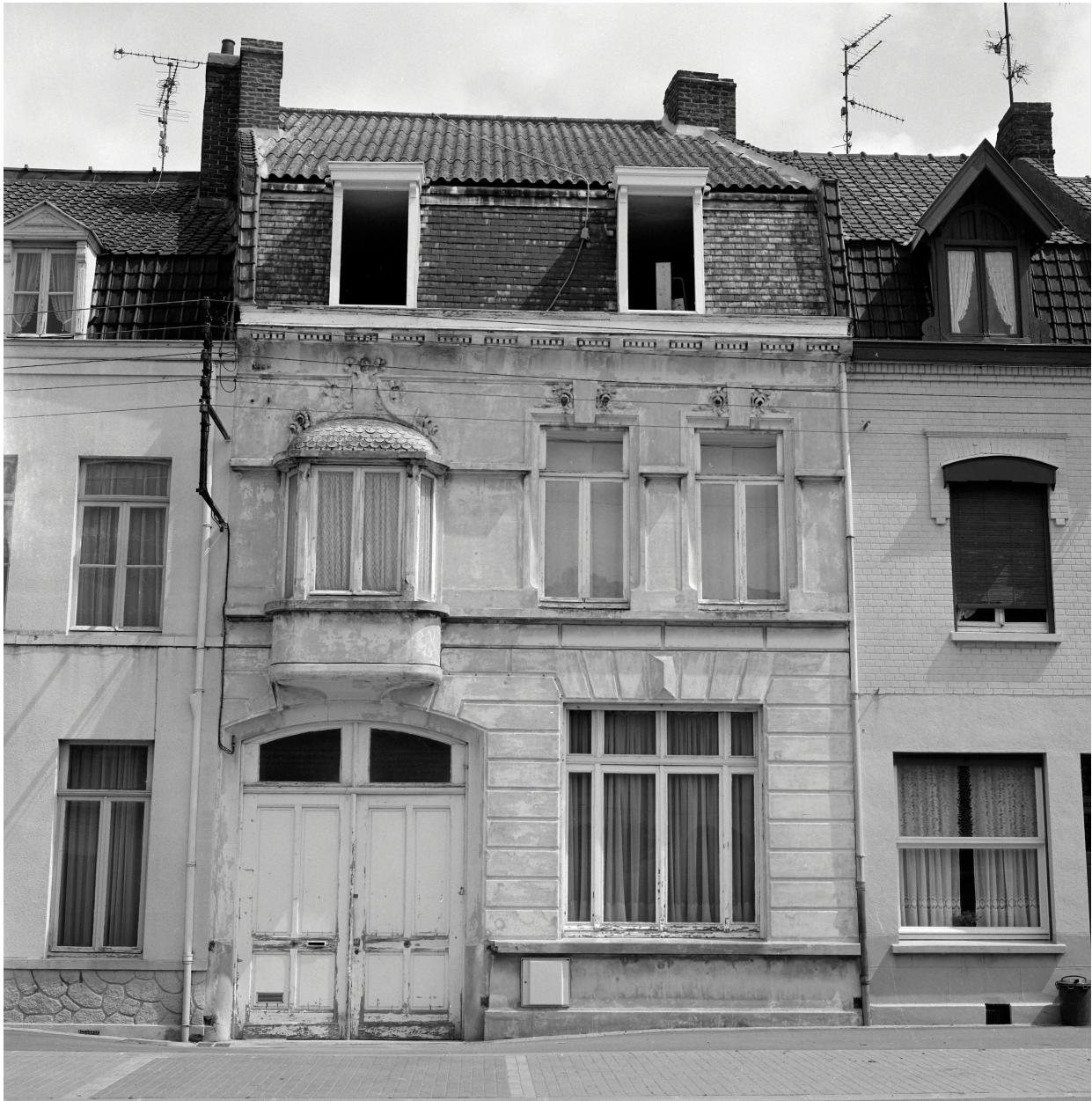
Élévation rue Jules-Ferry.
