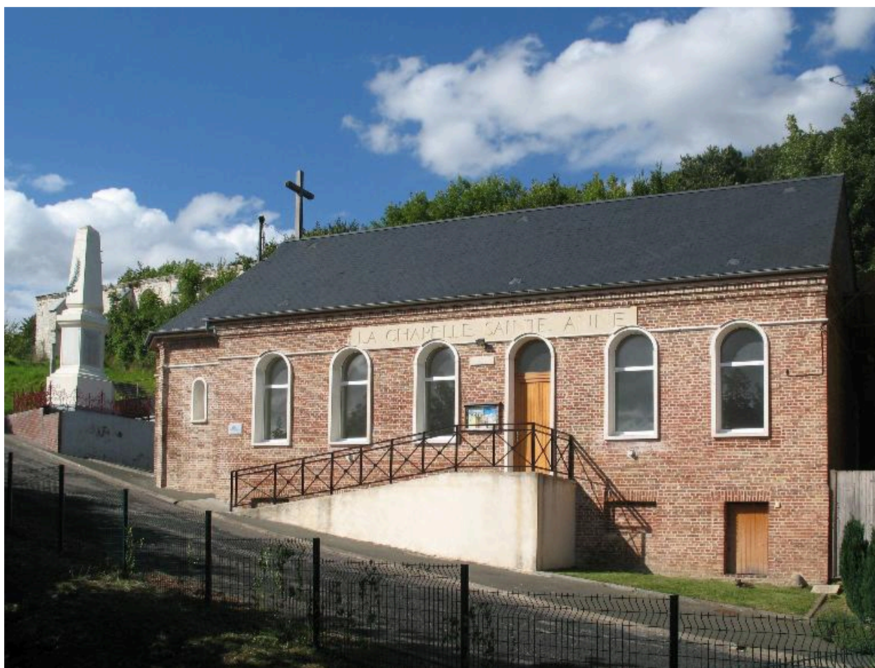
Façade sur de l'ancienne école des garçons, devenue chapelle Sainte-Anne.
