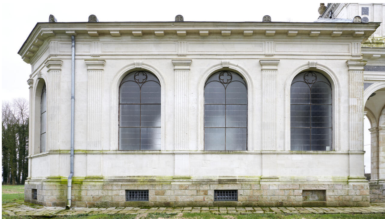
Élévation nord-ouest de l'unique vaisseau.
