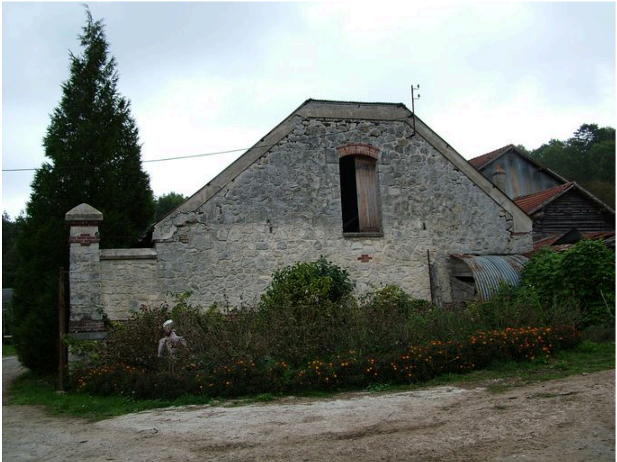
Vue du bâtiment de stockage situé à l'entrée de la propriété.
