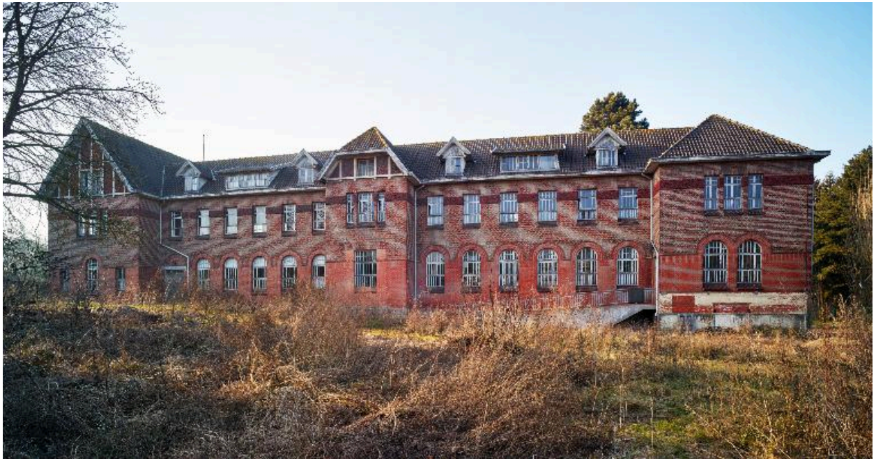
Bâtiment d'hospitalisation dit pavillon D9, élévation postérieure donnant sur le jardin intérieur, vue générale prise de face.
