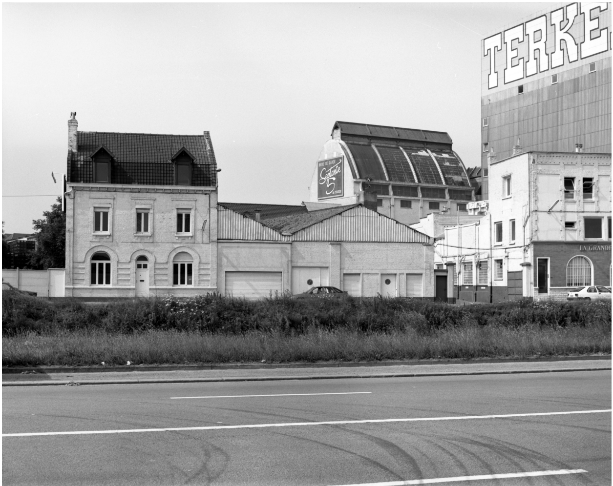
Logement patronal (avant 1920), élévation antérieure.
