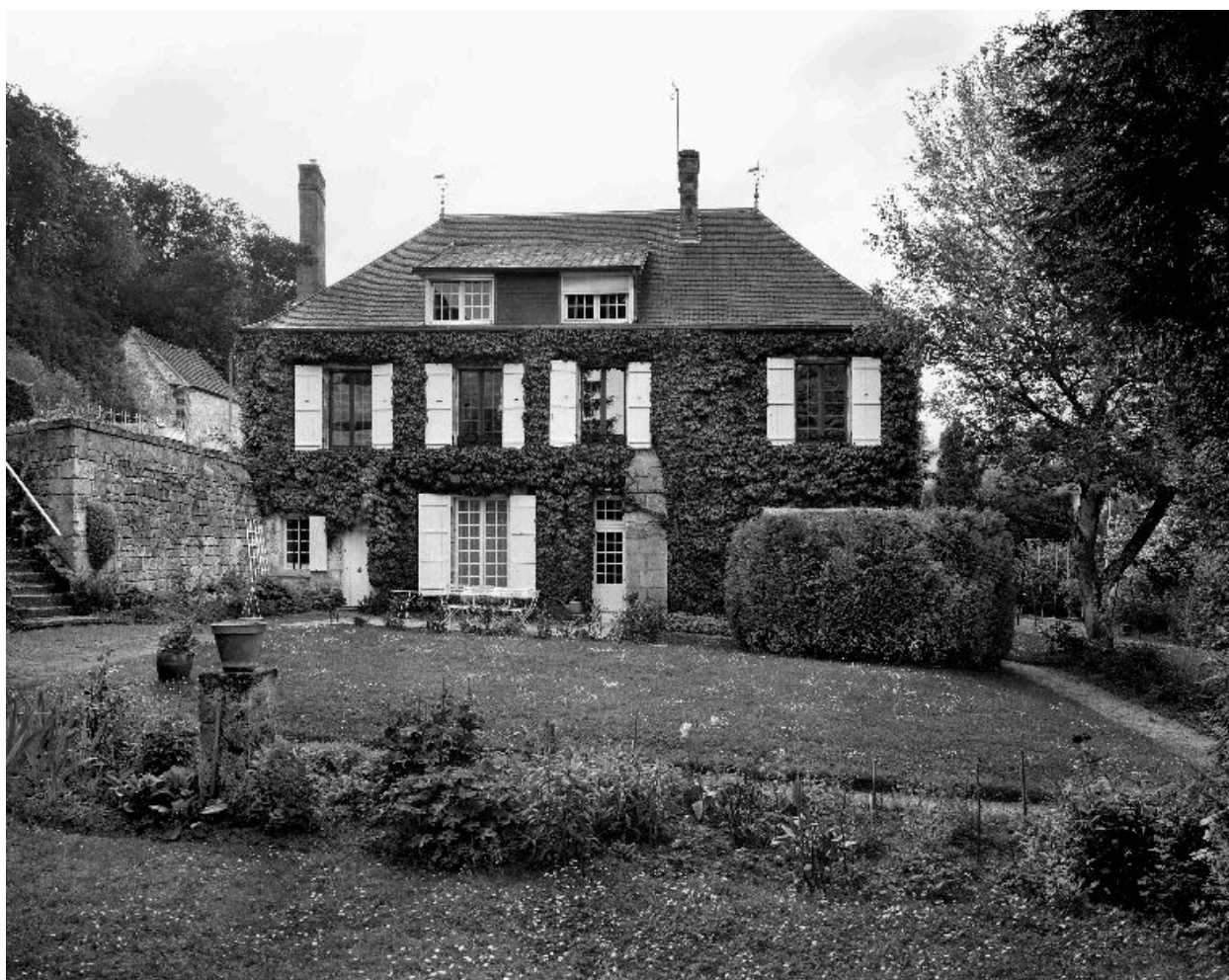
Vue de l'élévation sud-est.
