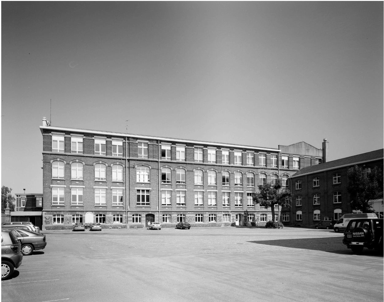
Vue générale des grands bureaux.
