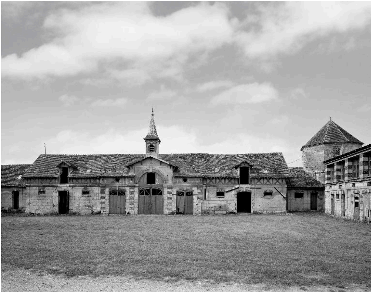
Vue de l'élévation sur cour de l'aile sud-ouest des communs (remises et écuries).
