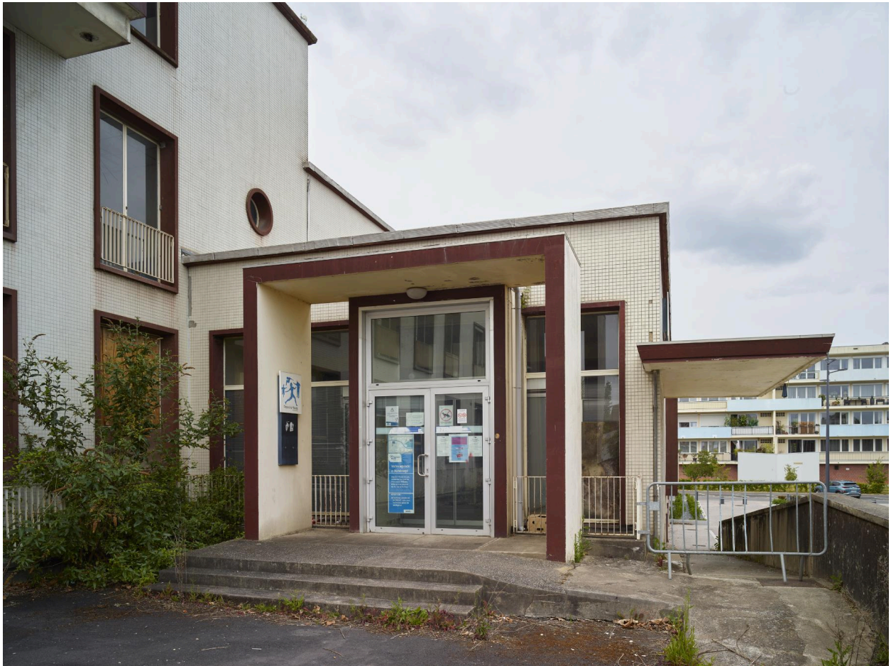
Vue de l'entrée de la CPAM, depuis la rampe.
