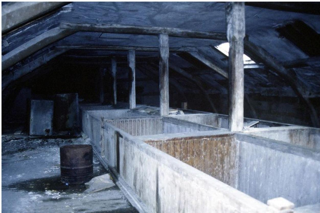
Bacs de stockage du caolin au dernier niveau sous comble de l'ancienne filature.
