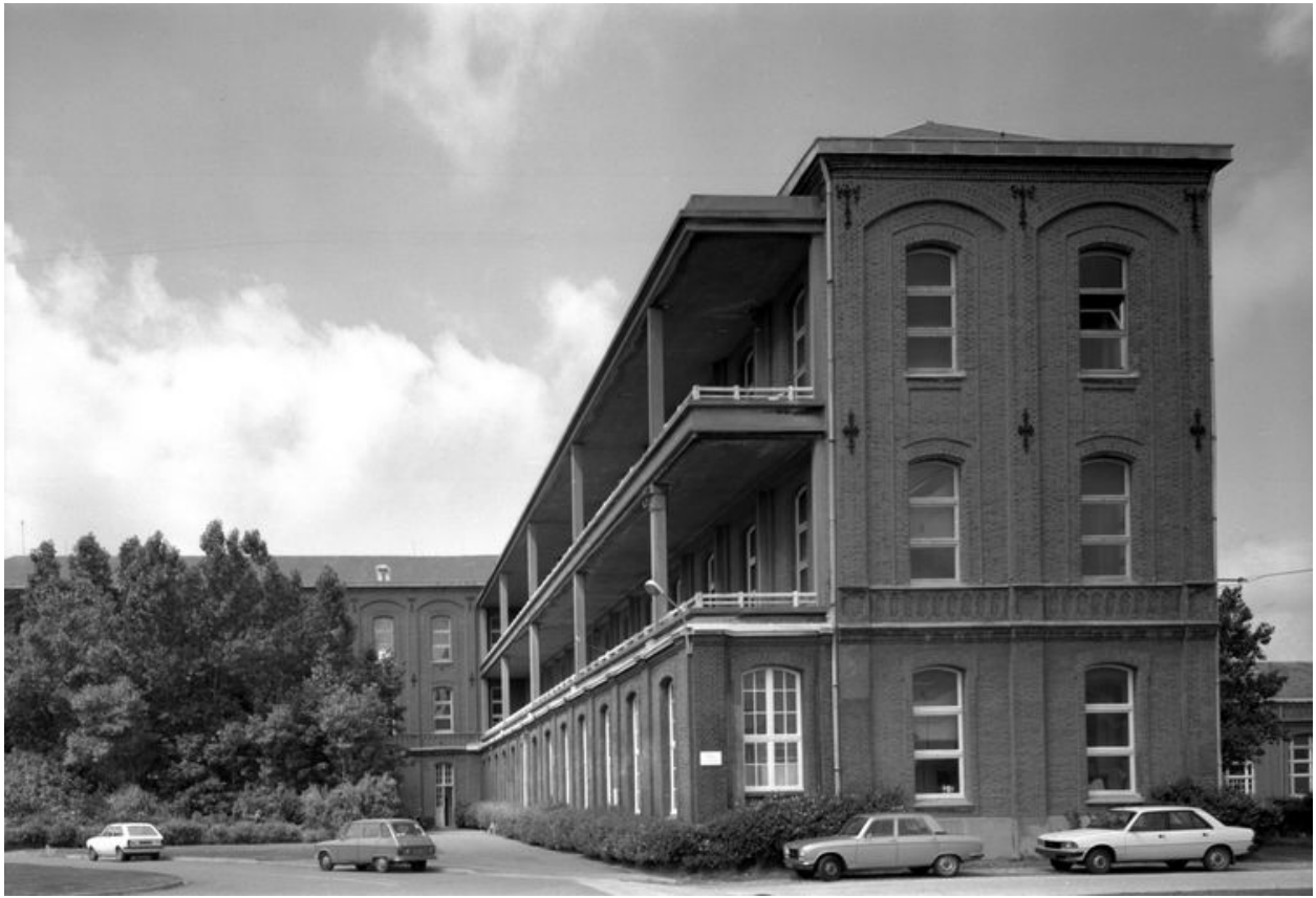
Corps de logis principal, extrémité orientale du bâtiment septentrional, face sud avec ses galeries de cure superposées ajoutées dans les années 1950, vue en enfilade
