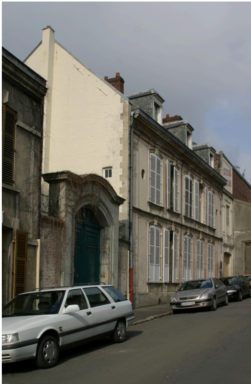
Façade antérieure du logement patronal.
