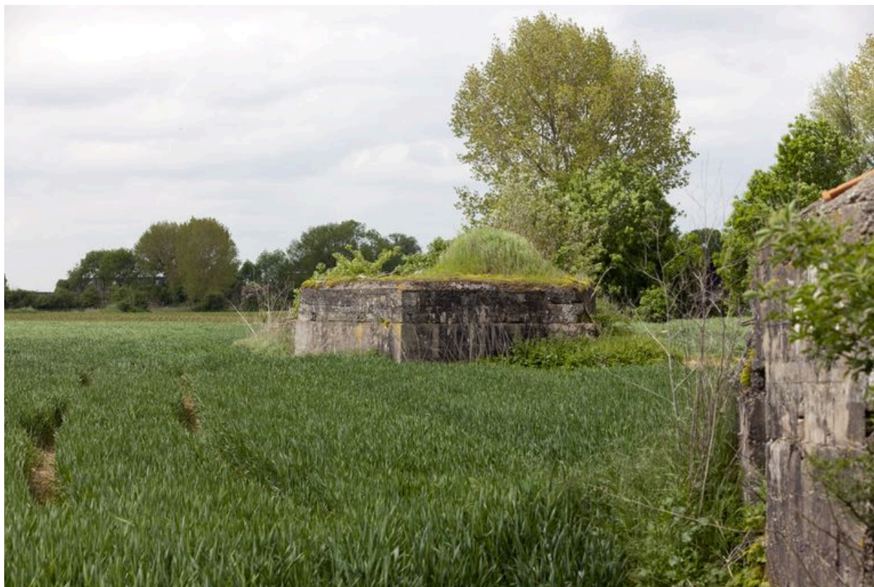
Vue des deux blockhaus d'artillerie (IA59004812 au fond).
