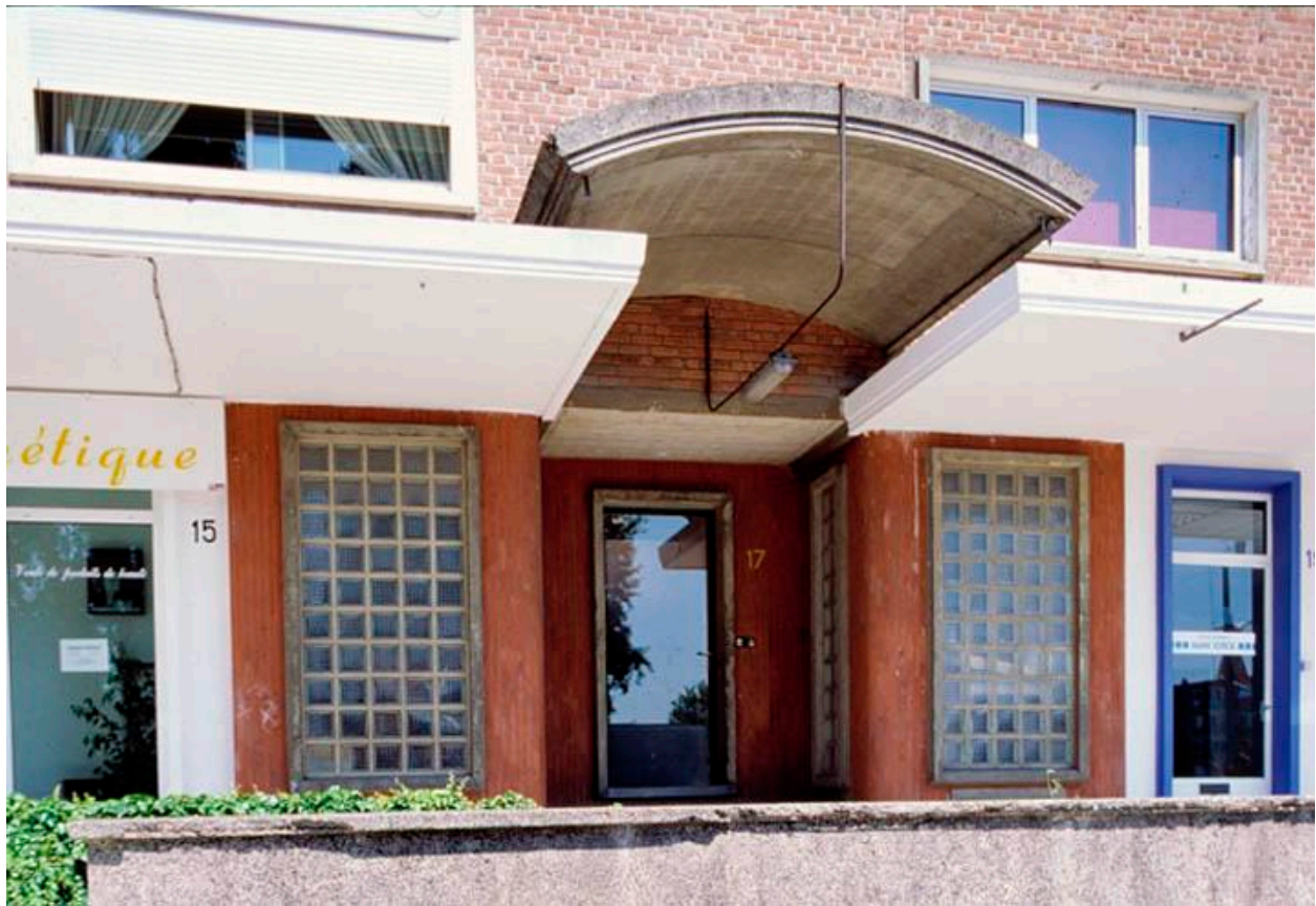
Vue de détail d'une entrée de l'immeuble : l'auvent.
