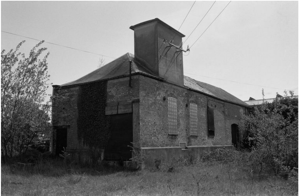
Chaufferie (?) et transformateur, en 1991.
