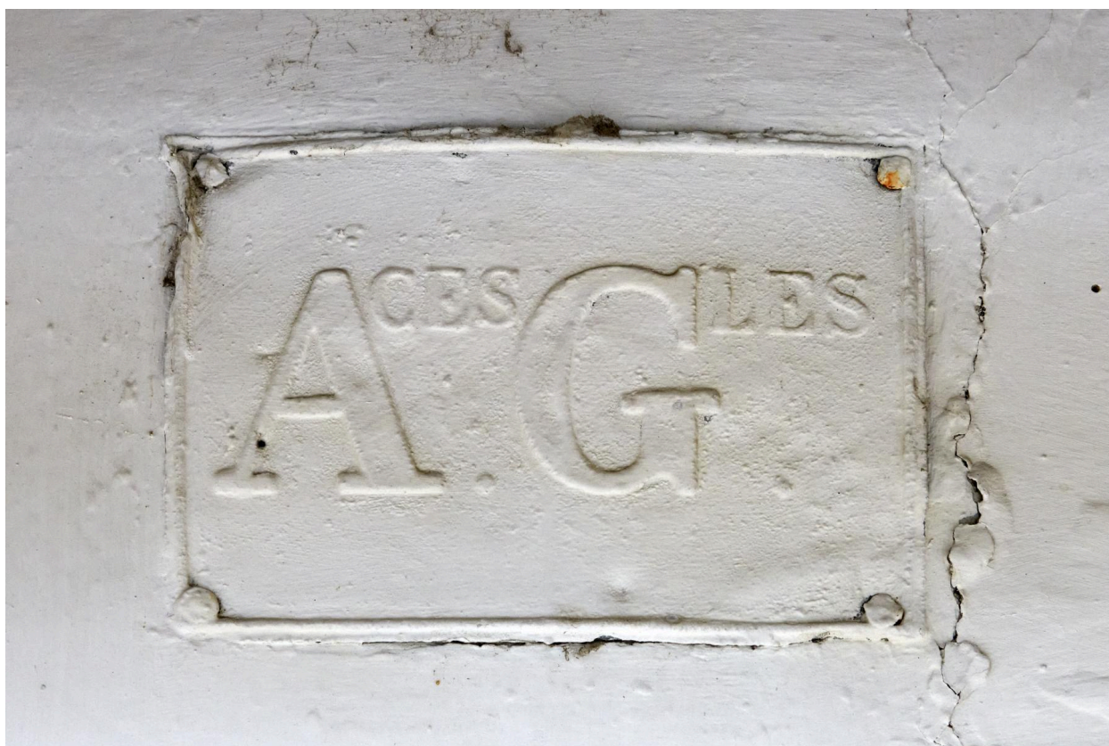
Plaque métallique sur le mur sud.
