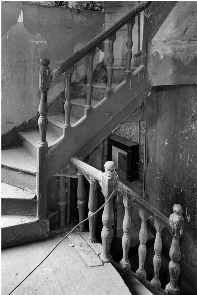
Vue de l'escalier, au niveau du 1er étage carré.
