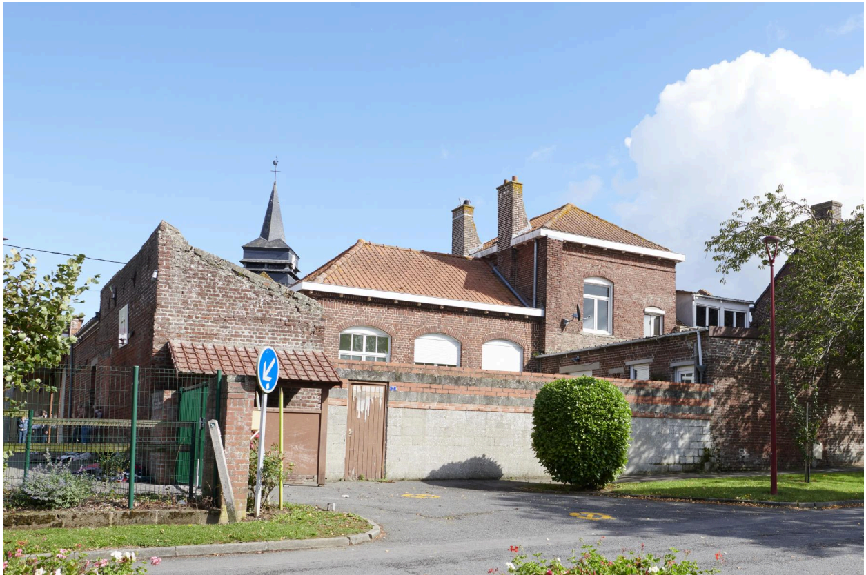
Vue depuis l'arrière.
