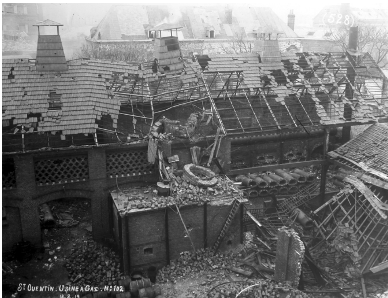
Le bâtiment des cornues de distillation en février 1919 : atelier en bordure du boulevard, avant restauration (AD Aisne).
