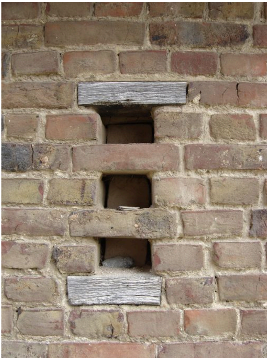
Vue des aérations sur rue.
