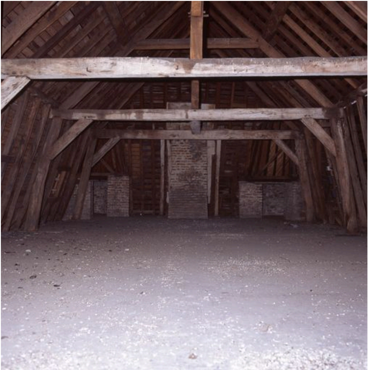
Corps de logis médiéval, intérieur, étage de comble : vue générale, charpente.
