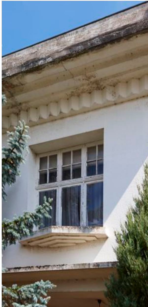
Façade, étage, détail : baie, auvent et corniche.
