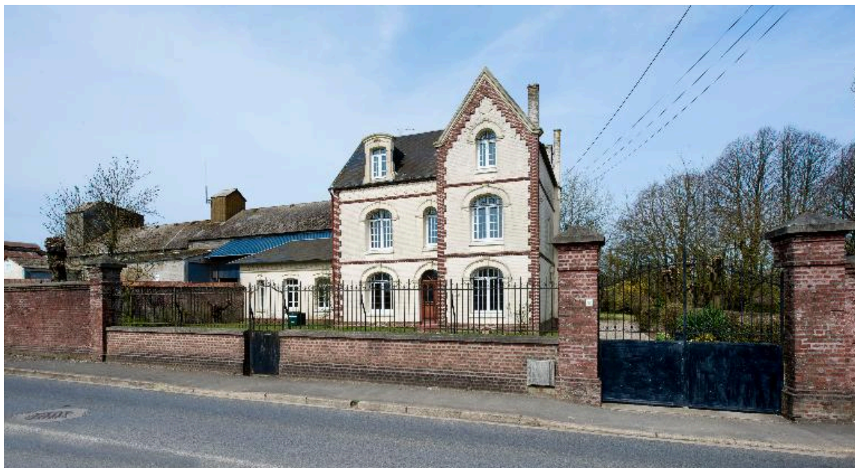
Vue générale depuis la rue Victor Hugo
