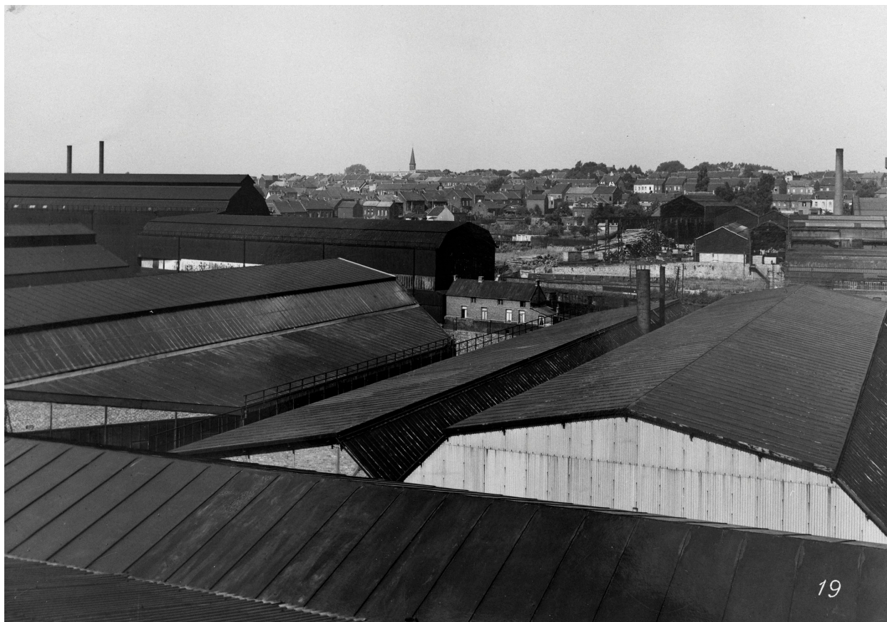
Vue générale vers le sud : les toitures de l'usine, la ville de Rouvroil dans le fond. Photographie ancienne, auteur inconnu, sans date (coll. part.).
