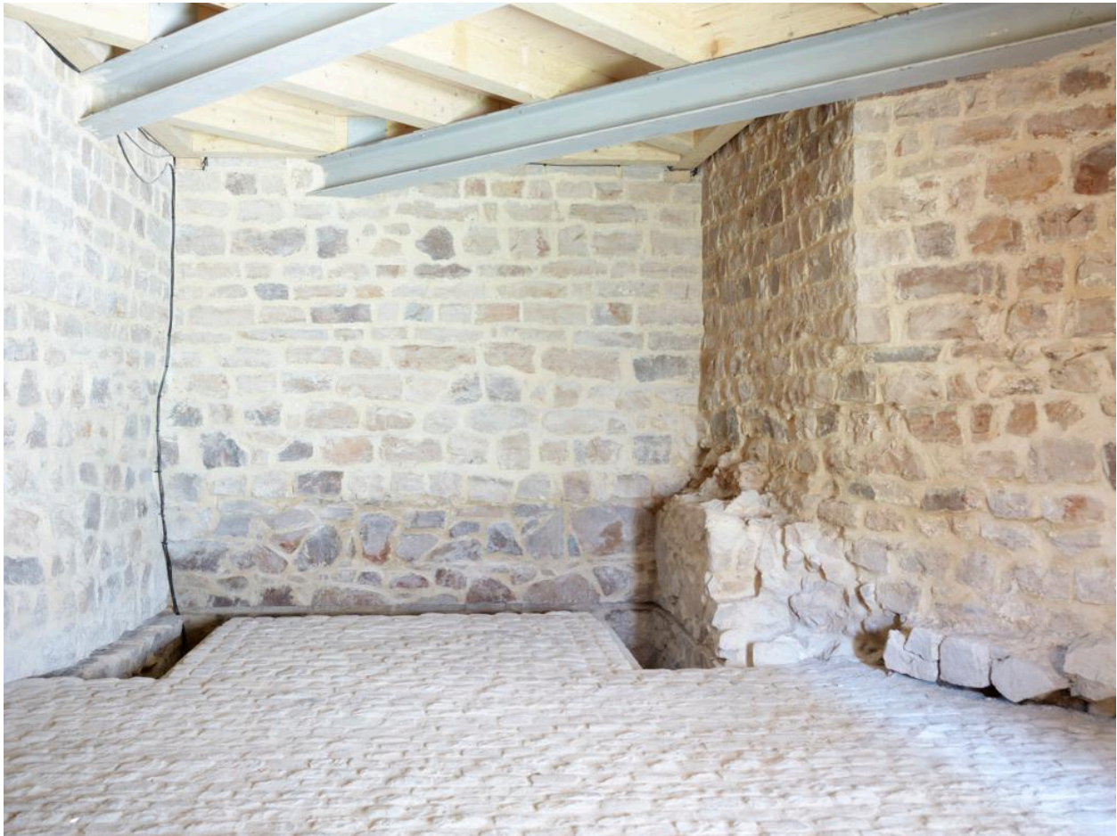
Vue de détail du rez-de-chaussée, vestiges des fondations médiévales des fortifications de Béthune.
