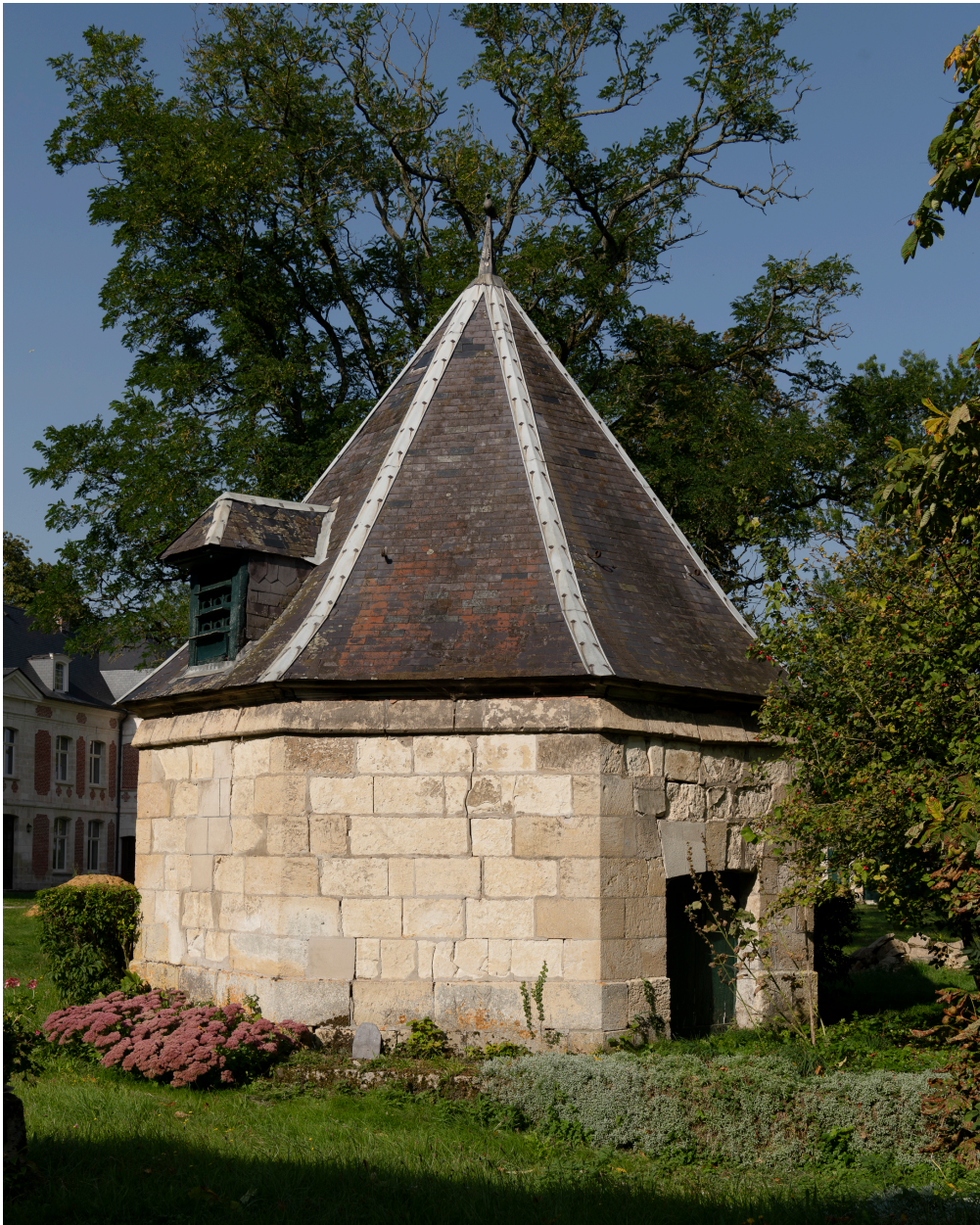
Pigeonnier et son entrée, vue depuis l'ouest.
