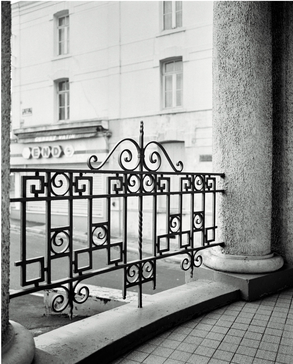
Détail de ferronnerie.
