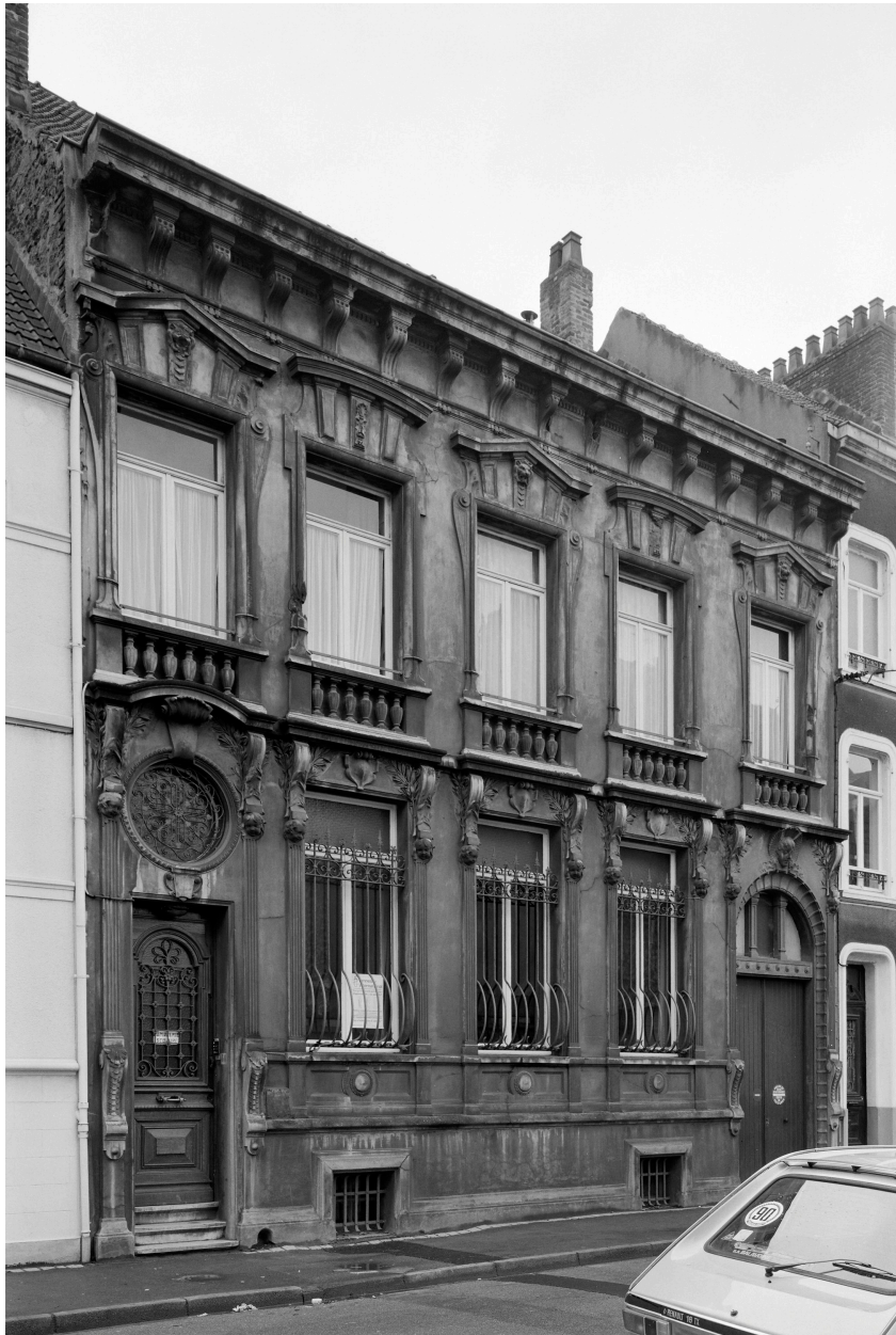
Vue générale sur voie.
