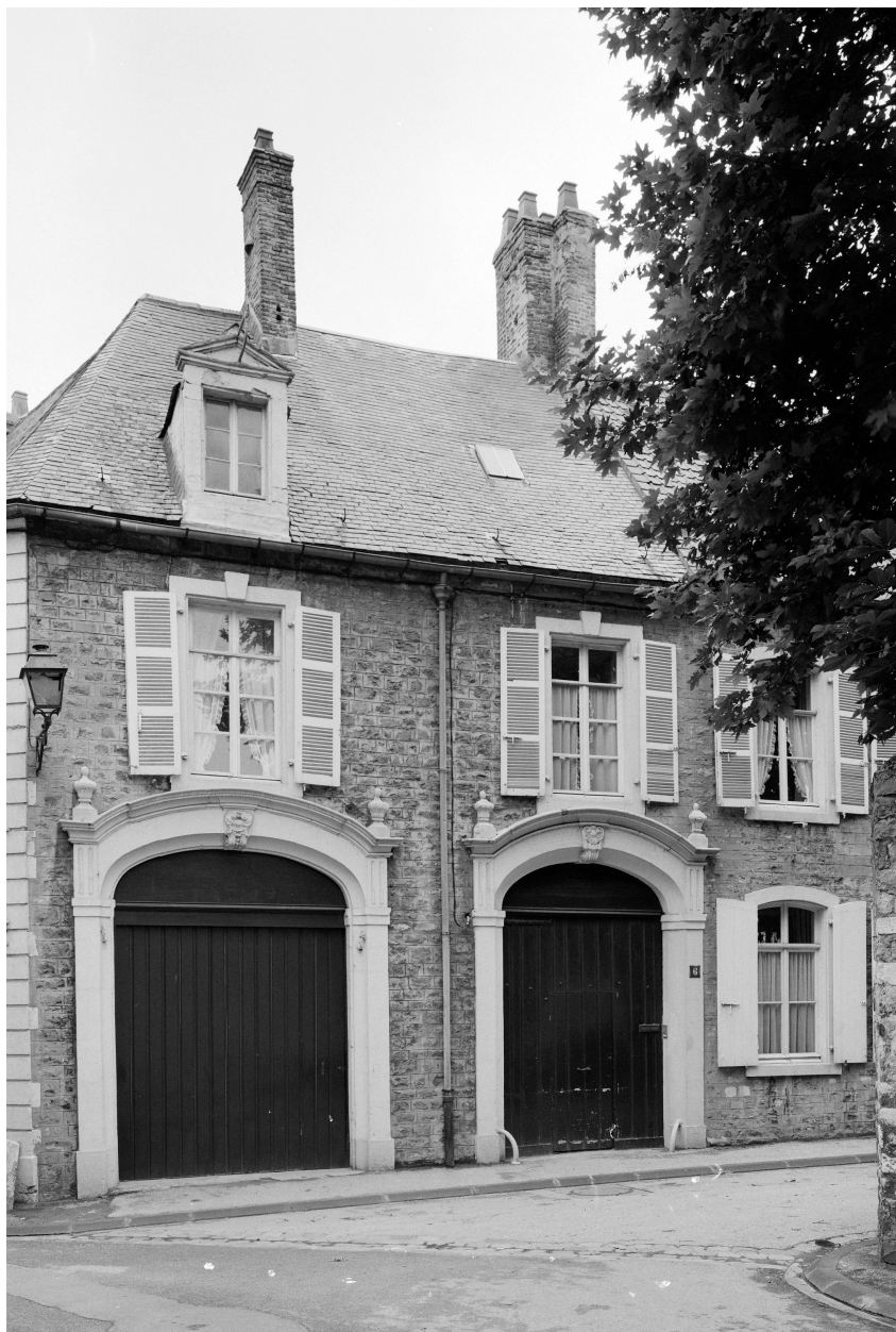
Façade sur d'Hautefeuille, partie sud.
