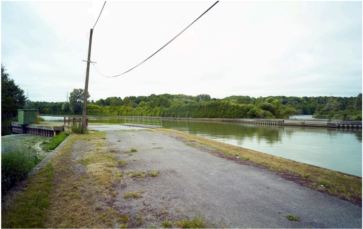
Vue depuis la rive est. Voie de circulation sur le pont canal.
