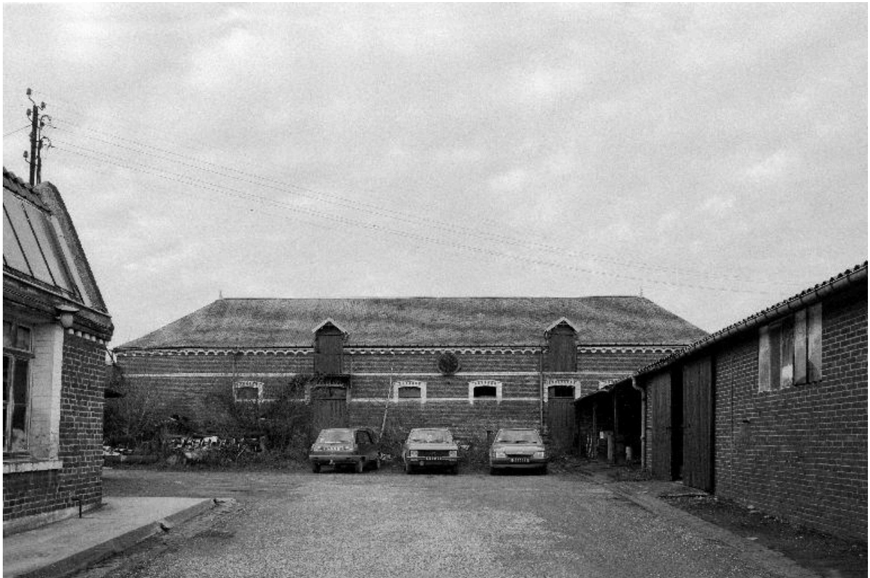
Ecuries, élévation antérieure.
