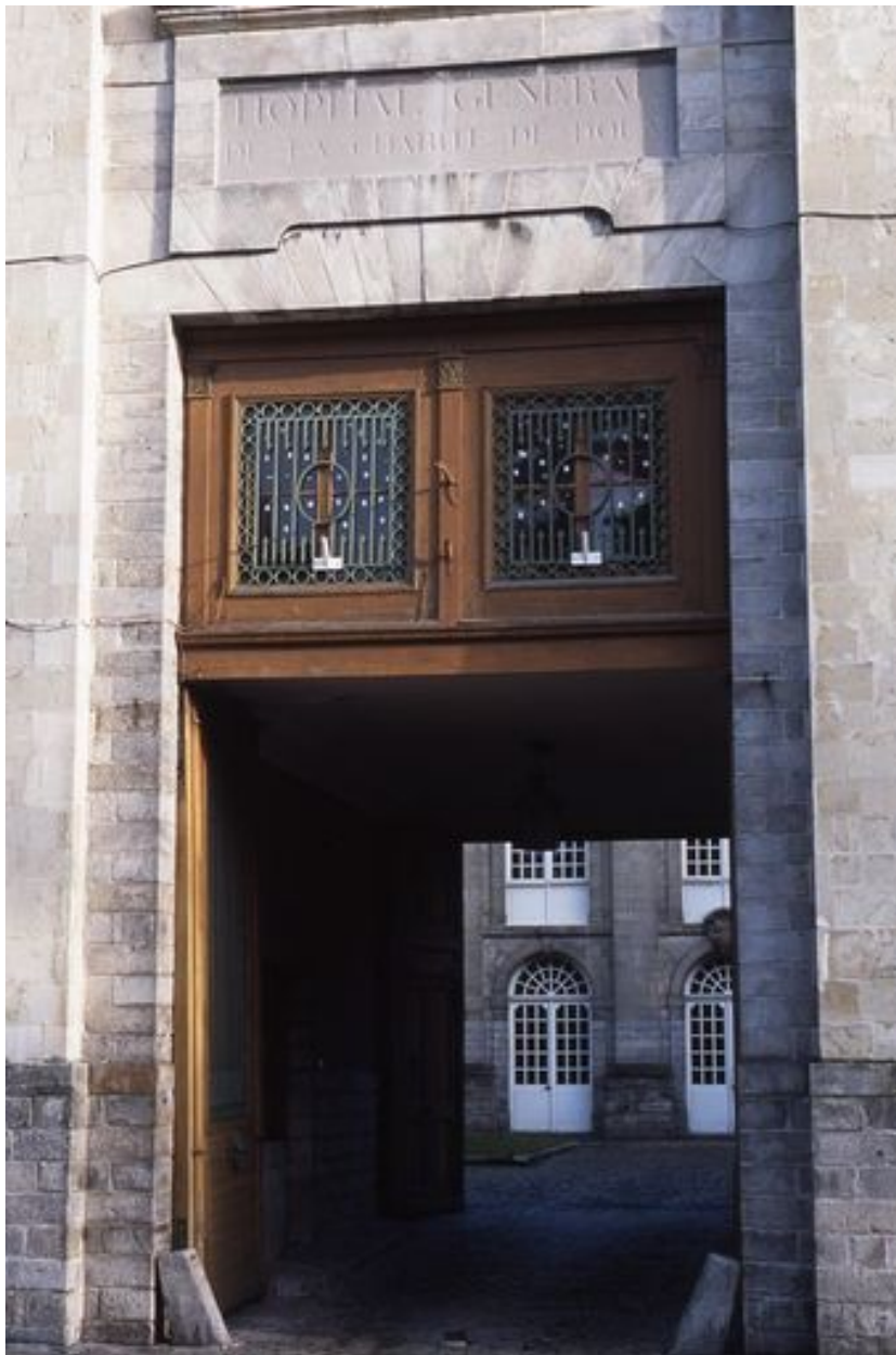
Bâtiment donnant sur la rue de Canteleu, destiné à abriter les infirmeries, élévation antérieure, avant-corps central, détail du portail d'entrée.
