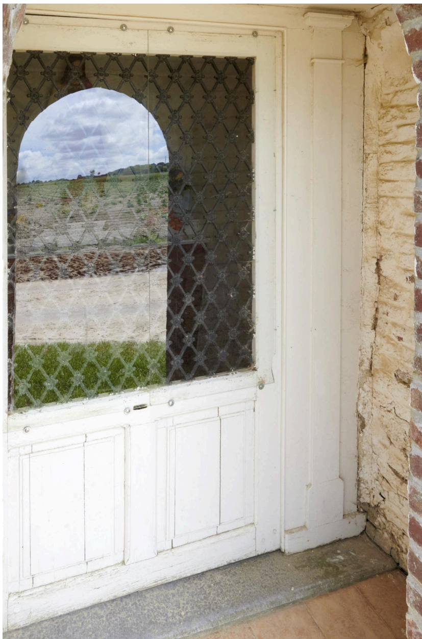
Détail. Porte et espace du vestibule ouvert (abri de pèlerin).
