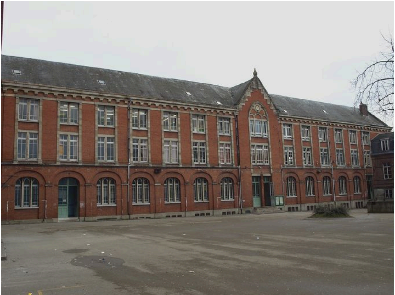
Aile Lehembre : vue générale
