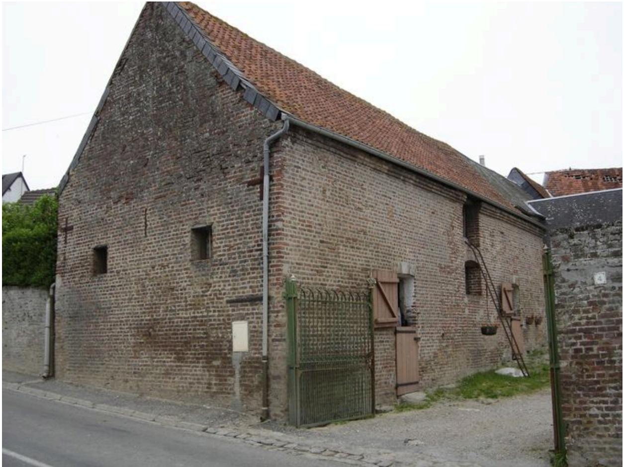
Vue des étables situées à l'est depuis la rue.
