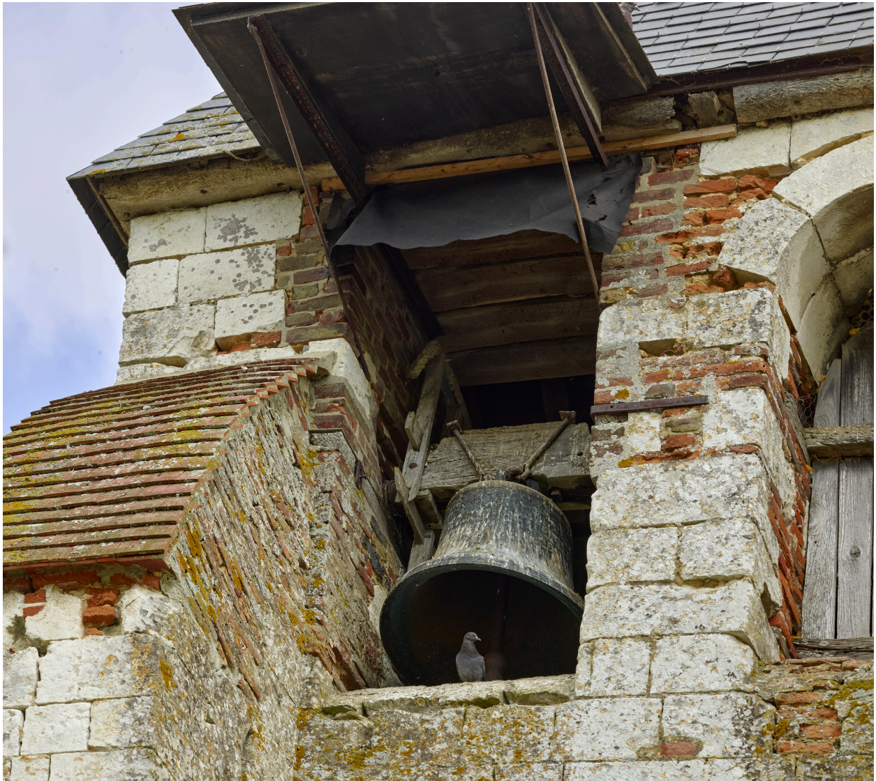
Détail de la cloche, depuis l'ouest.
