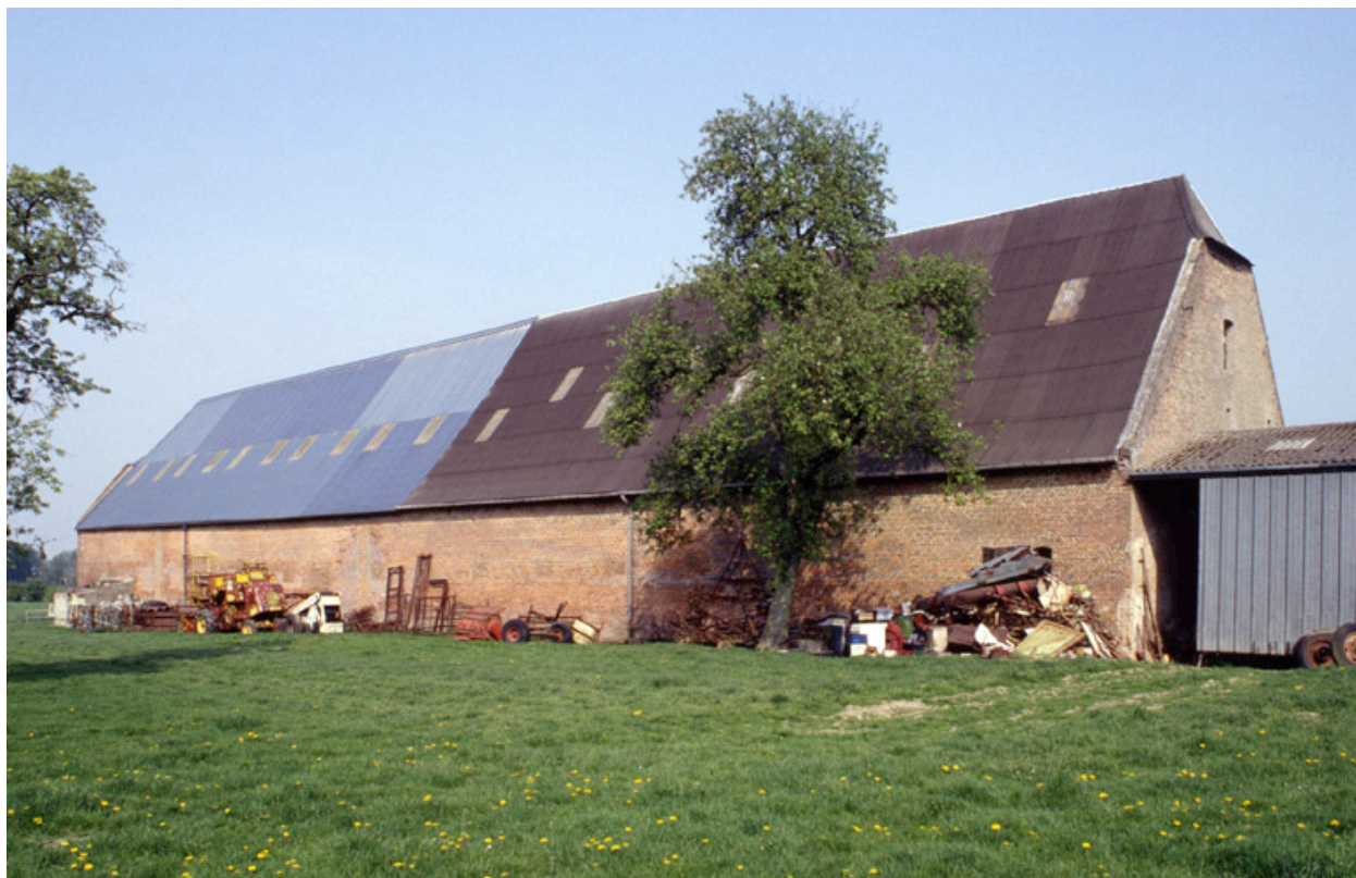
Vue d'ensemble sud-est de la grange.
