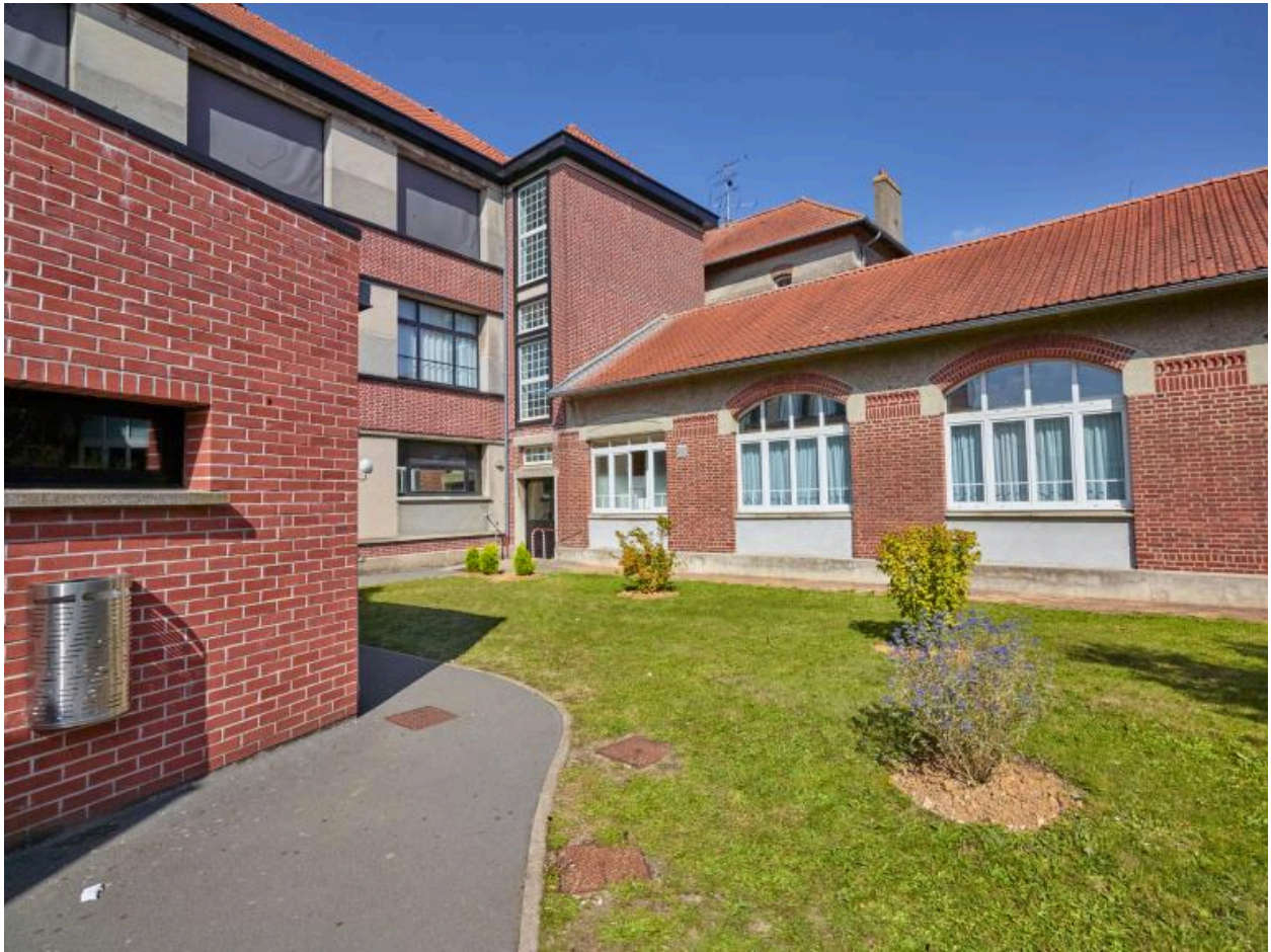
Ecole Blériot, vue de l'aile de construction récente et du bâtiment des classes depuis la cour.
