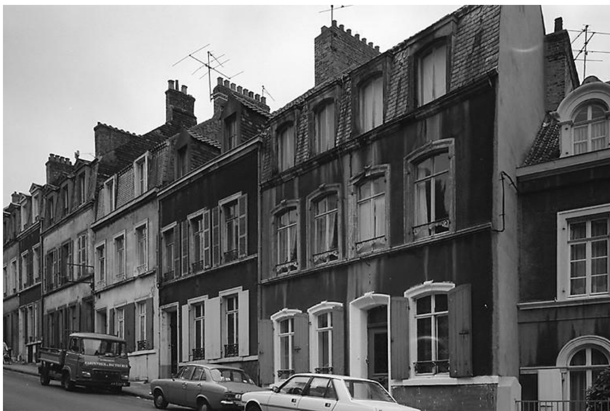
Vue d'angle sur voie.
