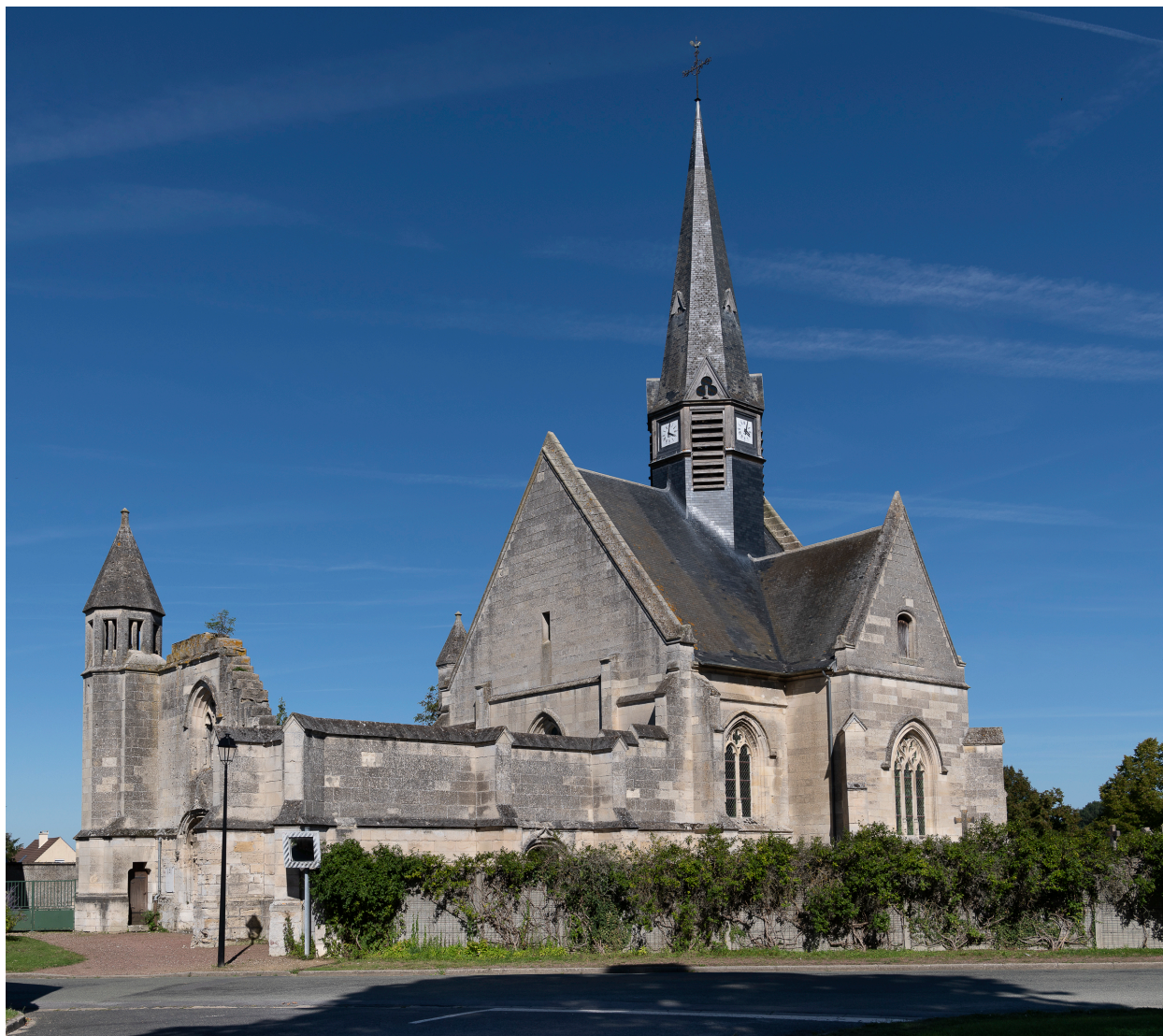
Vue générale prise depuis le sud-ouest.
